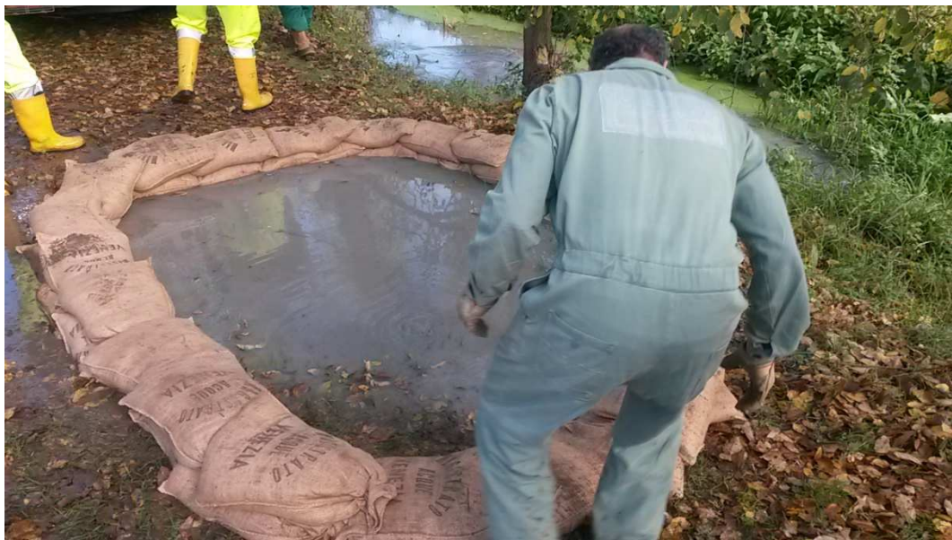
Figura 2-5: Fontanazzo con coronella di sacchetti di sabbia nei pressi dell'abitato di Corbola.
